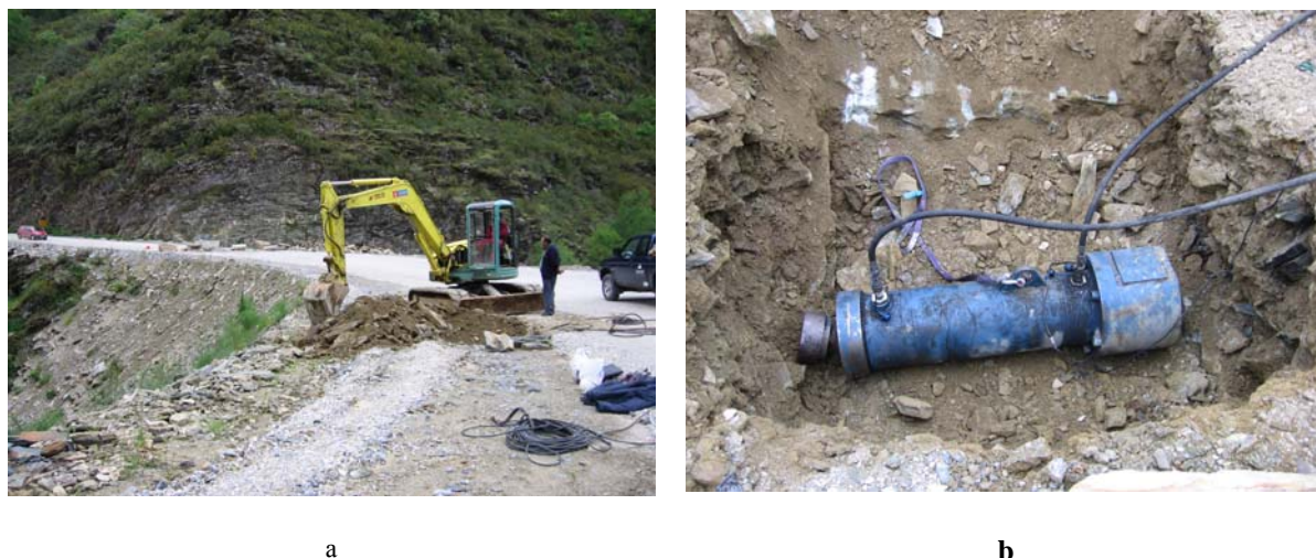
Fig. 7. Ensayo de hincamiento mediante cilindro hidráulico.
