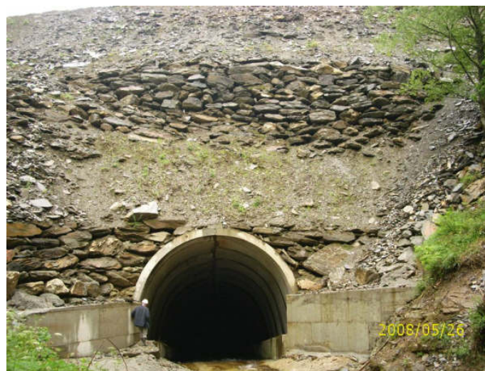
Fig. 3. Escollera y deslizamientos sobre la boca Norte del túnel.
