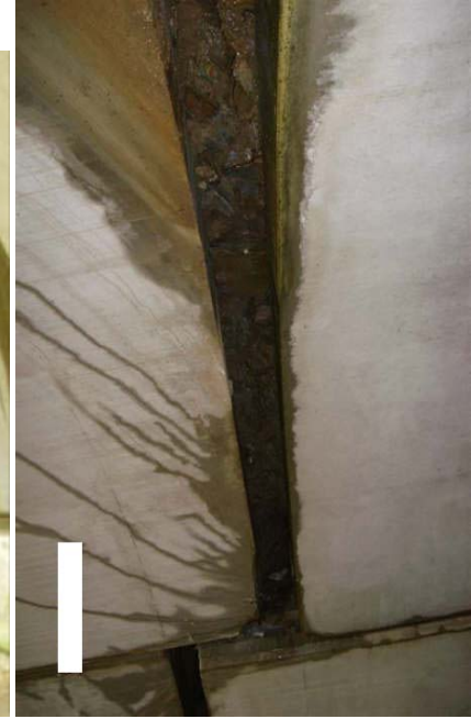
Fig. 4b. Separación de 20 cm entre dovelas.
