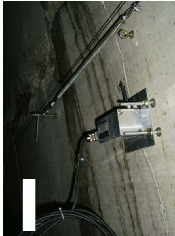
Fig. 5b. Colocación del sensor S2 en el interior del túnel.
