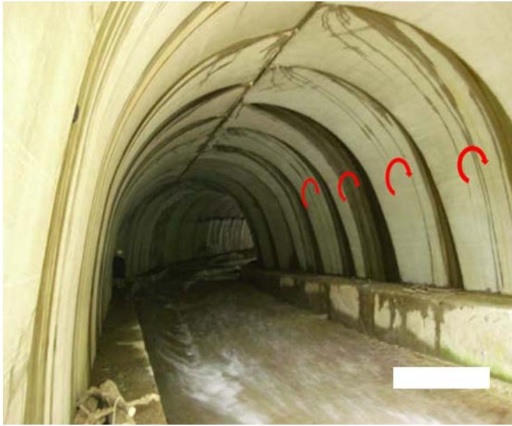
Fig. 4a. Desplazamientos, giros y filtraciones de agua
